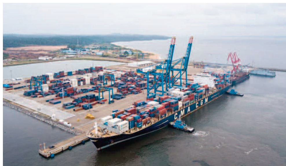
Le port en eau profonde de Kribi, une des réalisations de CHEC au Cameroun.
