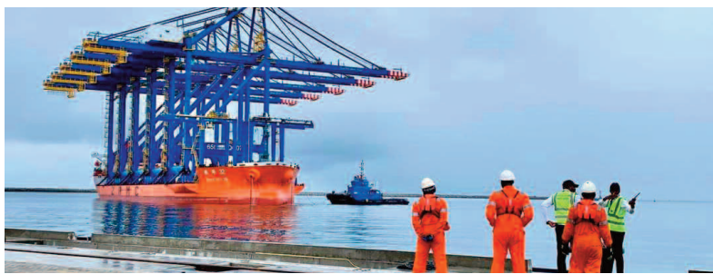
Accostage d'un nouveau navire sur le quai de la phase 2 au PAK, le 12 septembre dernier.
