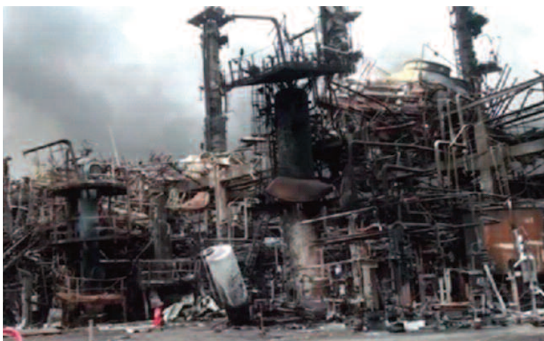
Les ruines de la raffinerie, après l'incendie de la Sonara le 31 mai 2019
