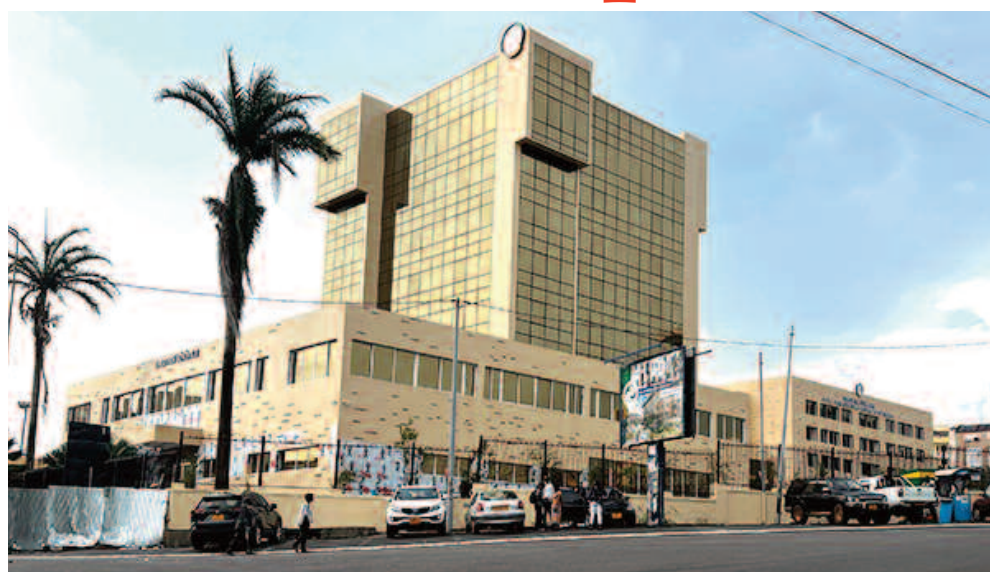
Le nouveau siège du Trésor public Gabonais
